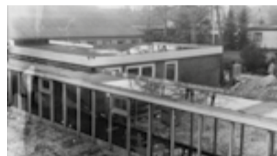
Im November 1976 sind die Arbeiten an der OS in Loccum in vollem Gange. Hier der Gang, der OS und Hauptschule miteinander verbinden wird. OBS Loccum.
