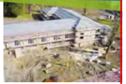
Die Sanierung der Kuranlagen ist ein mutiger Schritt gewesen – hier eine Ansicht auf die Wandelhalle während der Bauarbeiten. ade
