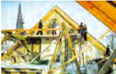
Ein Trauerspiel – so zeigt sich der Rathskeller zum Beginn der Sanierung. BHW
