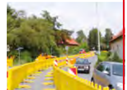
14 Monate Bauzeit haben in Loccum alle Anwohner:innen gelassen hingenommen. ade
